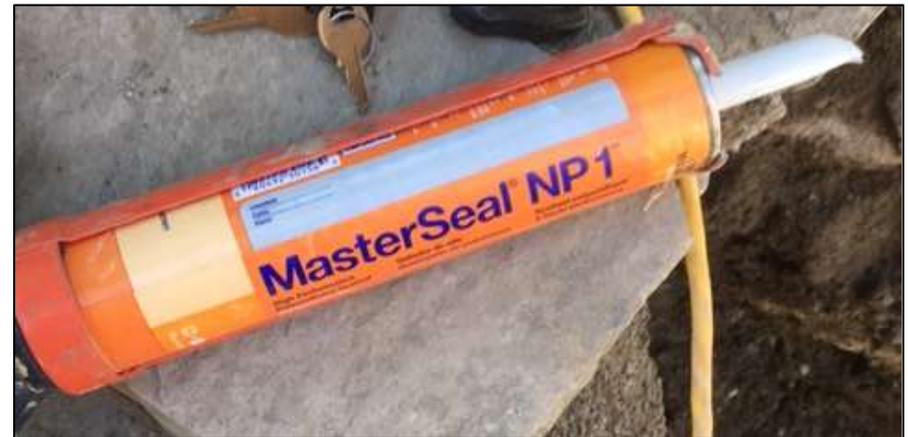
Pose d'un scellant MasterSeal NP1 sur la partie supérieure de la membrane verticale pour empêcher l'eau de drainage de pénétrer le long de la fondation.
