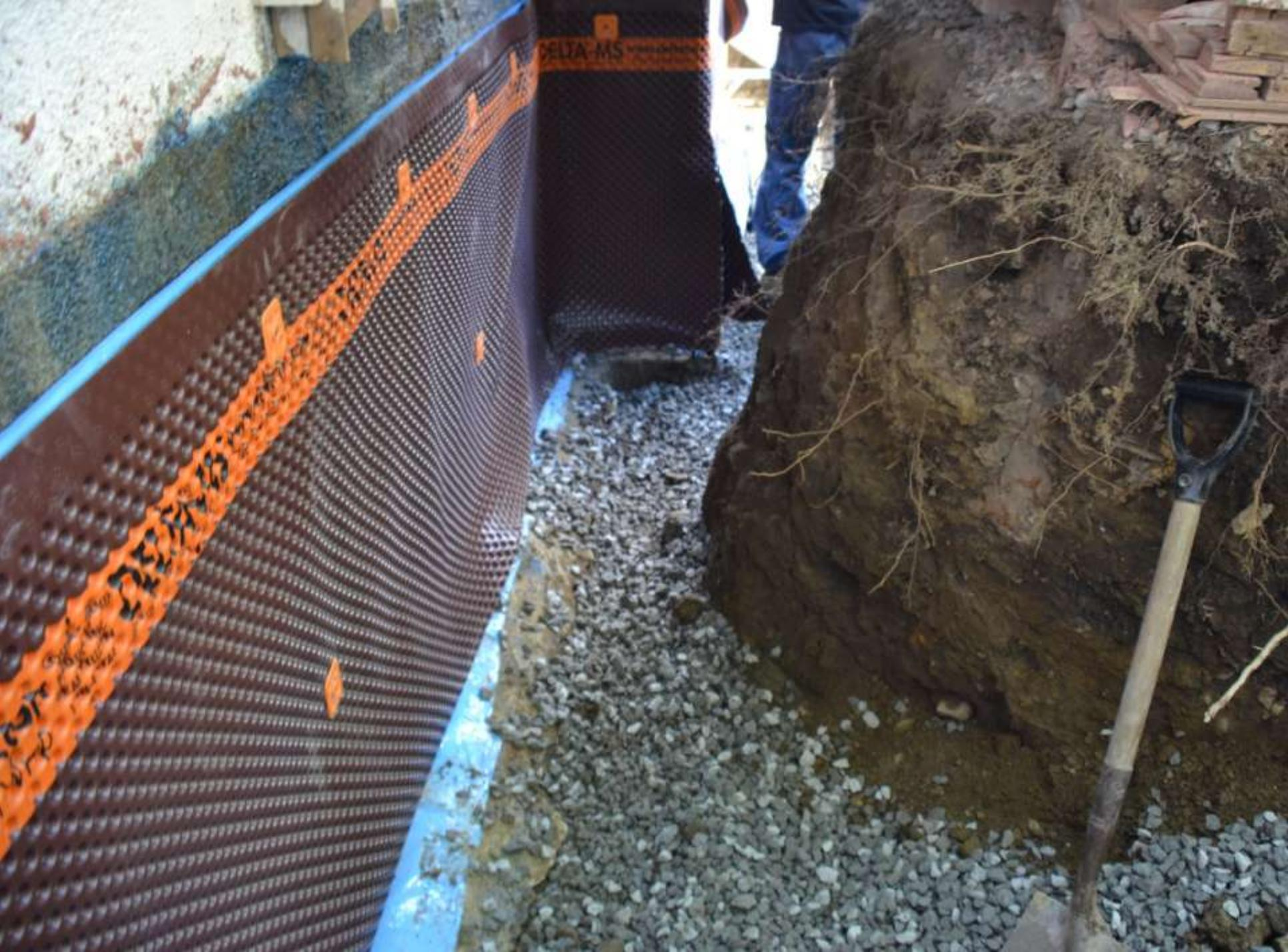
Pose d'un isolant bleu pour protéger la membrane verticale.
