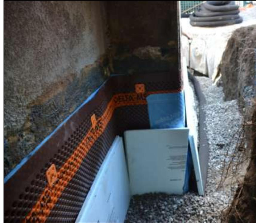
Le drain repose sur un lit de gravier  $\frac{3}{4}$  net et est enrobé d'une membrane empêchant les sédiments fins de le boucher avec le temps.
